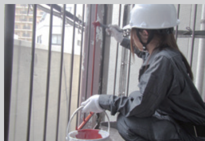
<現場研修(施工現場内)>
