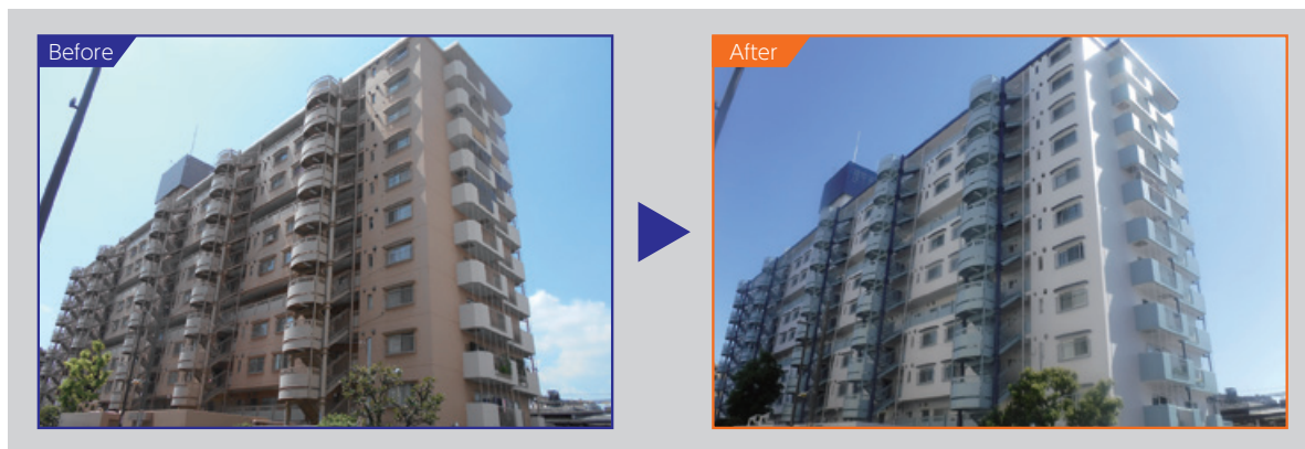
<外壁・鉄部の塗り替え>
