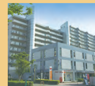
パークアールみさとテラス 2街区1号館・136戸
