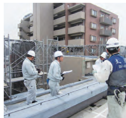
建物の建物調査・診断
